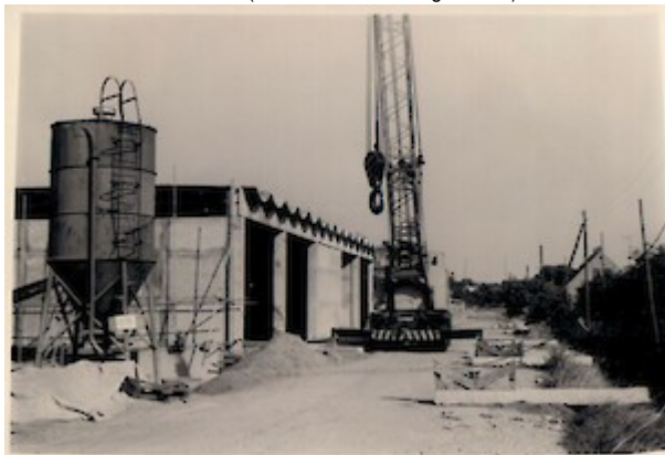
Eine Aufnahme aus der Bauphase: Ein Kran steht neben Rohbaustrukturen (© deuka Tiernahrung Cremer)
