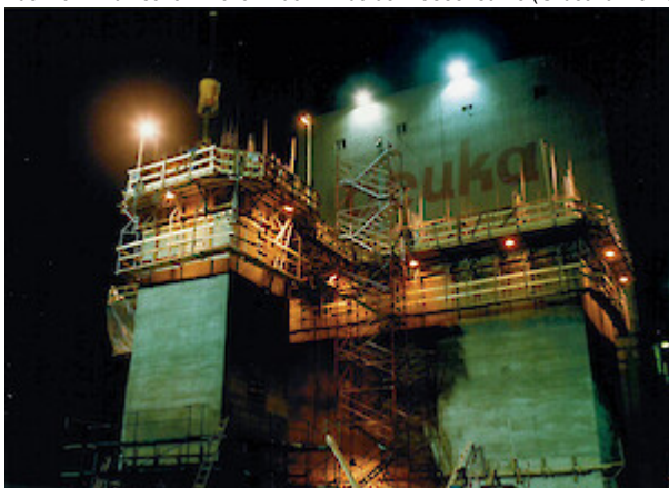
Die Bauarbeiten am deuka Werk Bramsche schreiten voran (© deuka Tiernahrung Cremer).
